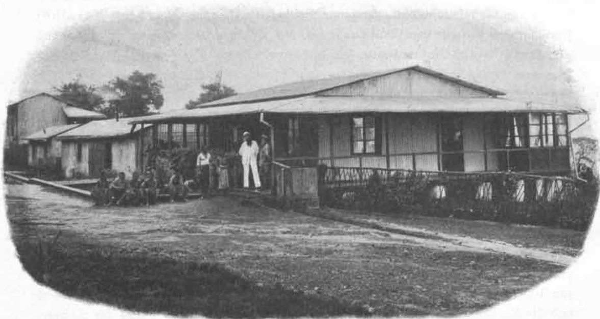
Stationsgebäude in Buea.
